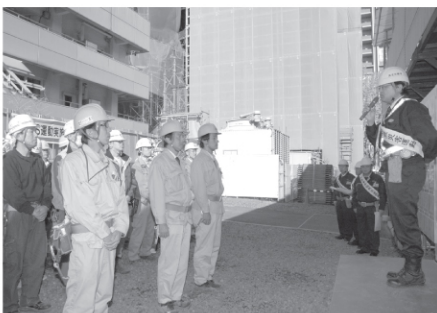
建設現場で激励する辻次長(右) (株)竹中工務店名古屋支店 名古屋科学館新築工事で)
