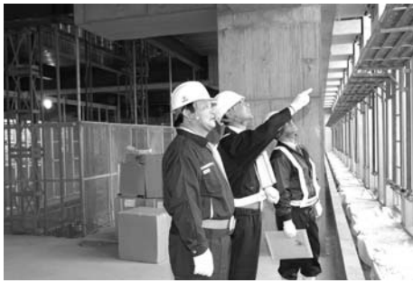
工事現場をパトロールする原田署長(中央(同上))
