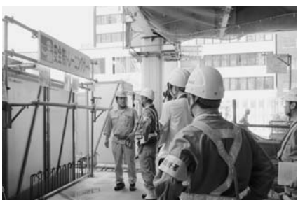
工事現場をパトロールする一行
