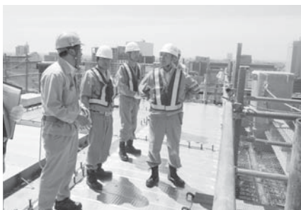
工事現場をパトロールする一行
