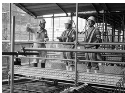
工事現場をパトロールする 一行
