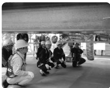
中村所長（右）より「スラブユニット工法」の説明を受ける
