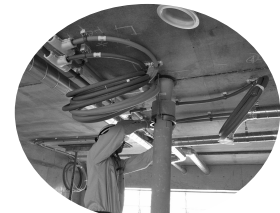
「安全第一」で行う配管工事作業
