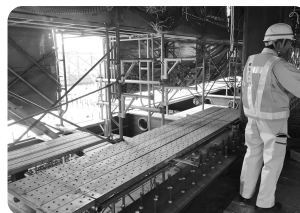
— 役員安全パトロールにて— 現場安全点検をする廣江社長
