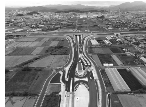
施工状況(東名高速静岡東スマート インターチェンジ工事)
