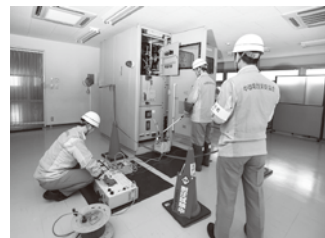
「電気設備点検作業」 竣工検査における絶縁耐力試験
