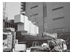
当社取扱商品の取付け、据付工事及びメンテナンス
